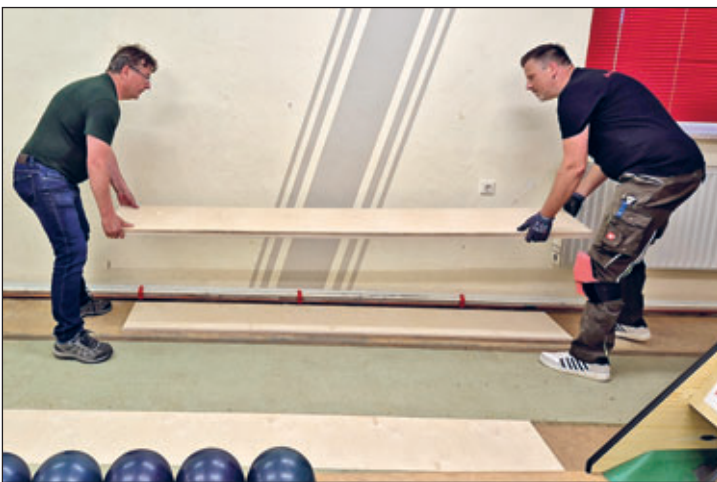
Die neuen Bohlen werden eingesetzt
